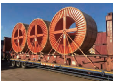
22kV CV-T ケーブル 出荷の様子
