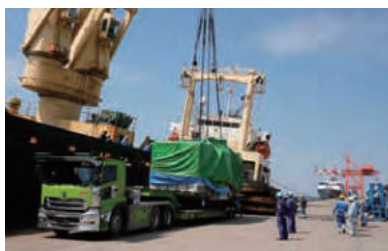
特別高圧変圧器 輸入の様子
