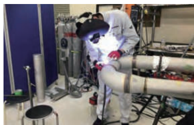
配管製造の作業風景
